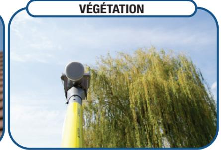
Une antenne installée trop près d'un débord de toiture, de l'arête d'un mur ou gênée par l'angle d'une toiture verra lui échapper une partie non négligeable du signal du satellite...
