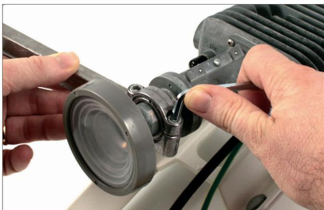
■ Une fois la puissance la plus élevée reçue, vissez définitivement la partie supérieure de la patte de fixation enserrant la tête d'émission/réception Internet tout en surveillant les niveaux du signal à l'écran, ceux-ci ne devant pas varier.
