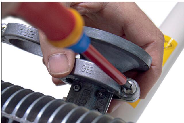
■ Une fois la puissance la plus élevée reçue, vissez définitivement la partie supérieure de la patte de fixation enserrant la tête d'émission/réception Internet tout en surveillant les niveaux du signal à l'écran, ceux-ci ne devant pas varier.
